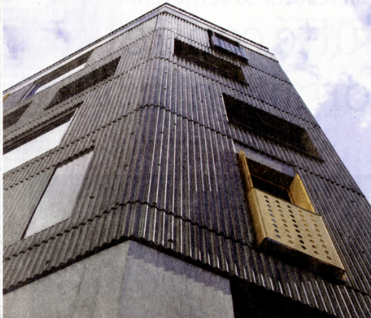
Immeuble du 72, rue Doudeauville, dans le 18 e arrondissement, à Paris. NICOLAS BOREL
